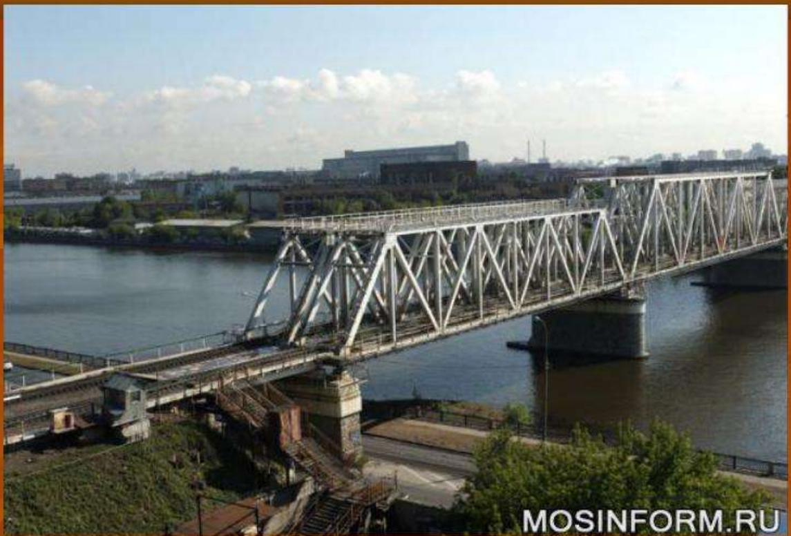
Треугольники в конструкции мостов.
